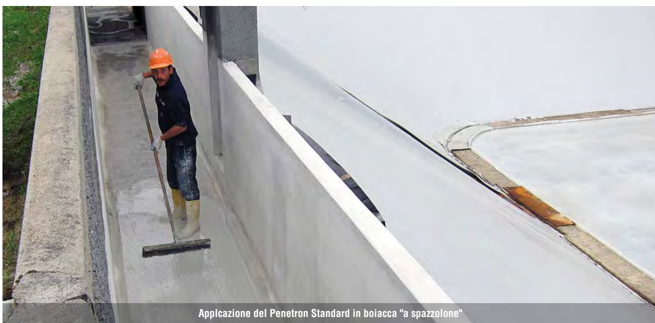
Applicazione del Penetron Standard in boiaccia "a pennellata"
