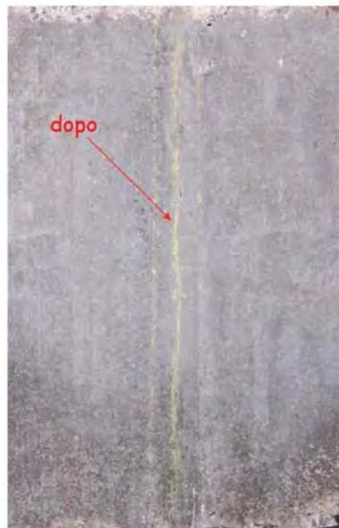
In entrambi i casi si osserva un significativo miglioramento nel recupero della capacità portante post-fessurativa grazie all'aggiunta dell'additivo; ciò è chiaramente attribuibile alla capacità dell'additivo di reagire con l'umidità atmosferica e con i prodotti di idratazione del cemento, formando quei prodotti di reazione in grado appunto di risigillare le fessure.
