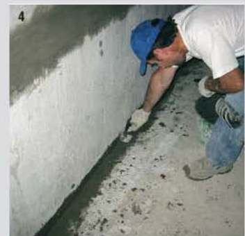
Photo 1) Vue générale d'infiltrations typiques dans des structures en béton enterrées Photo 2) Ouverture avec encaissement des « non-conformités » et traitement de fond avec Penetron Standard Photo 3) Masticage avec le mortier Penecrete Malta Photo 4) Traitement final des réparations avec Penetron Standard
