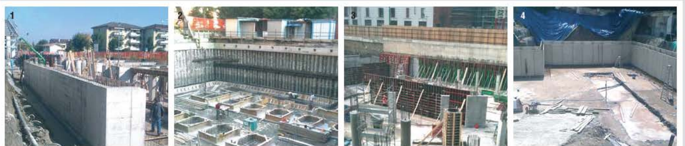
Photo 1 ) Structures enterrées double coffrage à panneaux traditionnels (Immeuble résidentiel Cascina Casella, Cremona) - Photo 2 ) Structures enterrées contre pieux (Immeuble résidentiel Via Monte Ortigara, Turin) - Photo 3 ) Structures enterrées contre diaphragmes (Immeuble résidentiel Via Viganò, Milan) - Photo 4 ) Coffrage perdu double plaque BILBOTPROOF® (Residenziale Strada Valsalice, Torino)
