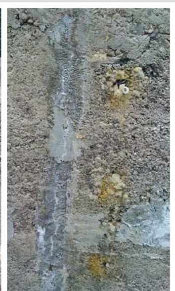
Photo 1) Mélange du Penetron Inject, bicomposant, dans une pompe à coulis cimentaire fluide prévue à cet effet - Photo 2) Préparation des packers à injection et injection du coulis visqueux sous pression - Photo 3) Le Penetron Inject peut être utilisé en association à des résines polyuréthaniques hydro-expansives élastiques - Photo 4) Réaction cristalline de scellement dans une fissuration
