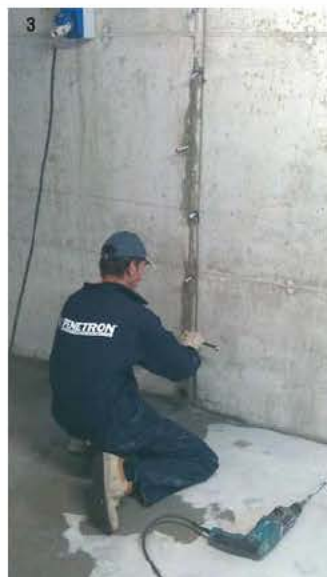
Photo 1) Lésion avec fuite d'eau en poussée hydraulique - Photo 2) Préparation des trous pour les packers d'injection - Photo 3) Fixation des packers étanches dans les trous - Photo 4) Injection, au moyen d'une pompe électrique, de la résine hydro-expansive élastique.
