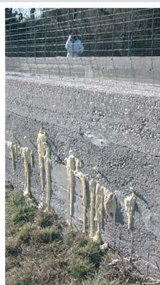
Photo 1) Mélange du Penetron Inject, bicomposant, dans une pompe à coulis cimentaire fluide prévue à cet effet - Photo 2) Préparation des packers à injection et injection du coulis visqueux sous pression - Photo 3) Le Penetron Inject peut être utilisé en association à des résines polyuréthaniques hydro-expansives élastiques - Photo 4) Réaction cristalline de scellement dans une fissuration
