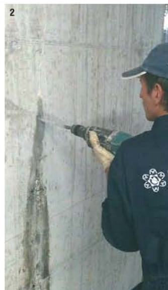
Photo 1) Lésion avec fuite d'eau en poussée hydraulique - Photo 2) Préparation des trous pour les packers d'injection - Photo 3) Fixation des packers étanches dans les trous - Photo 4) Injection, au moyen d'une pompe électrique, de la résine hydro-expansive élastique.
