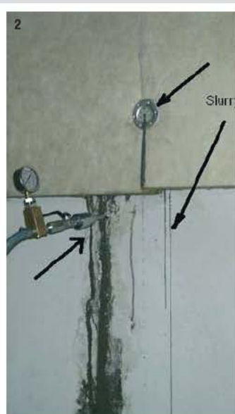
Photo 1) Mélange du Penetron Inject, bicomposant, dans une pompe à coulis cimentaire fluide prévue à cet effet - Photo 2) Préparation des packers à injection et injection du coulis visqueux sous pression - Photo 3) Le Penetron Inject peut être utilisé en association à des résines polyuréthaniques hydro-expansives élastiques - Photo 4) Réaction cristalline de scellement dans une fissuration
