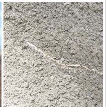
Photo 1) Béton projeté imperméable d'assainissement du profil endommagé d'une galerie ferroviaire - Photo 2 - 3) Béton projeté imperméable contre pieux de parking enterré Photo 4) Croissance cristalline dans le temps véhiculant l'humidité dans les fissurations et porosités résiduelles du béton projeté
