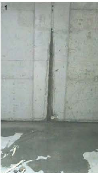
Photo 1) Lésion avec fuite d'eau en poussée hydraulique - Photo 2) Préparation des trous pour les packers d'injection - Photo 3) Fixation des packers étanches dans les trous - Photo 4) Injection, au moyen d'une pompe électrique, de la résine hydro-expansive élastique.
