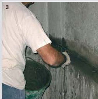
Photo 1) Vue générale d'infiltrations typiques dans des structures en béton enterrées Photo 2) Ouverture avec encaissement des « non-conformités » et traitement de fond avec Penetron Standard Photo 3) Masticage avec le mortier Penecrete Malta Photo 4) Traitement final des réparations avec Penetron Standard
